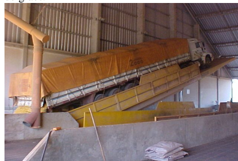
Figura 2. Elevador Agrícola (Tombador)
